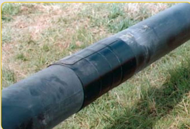
Einsatz von Bitumenbändern im Behälterbau
