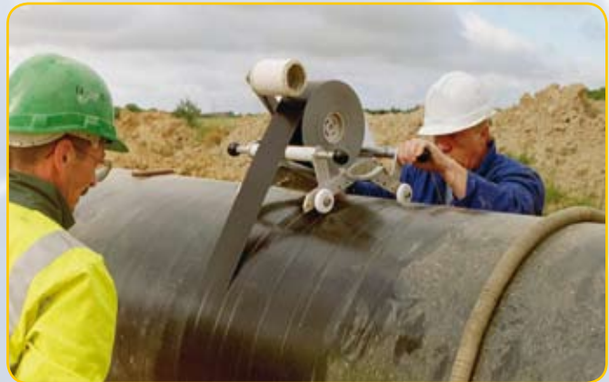
Nachisolierung von Schweißverbindungen auch an großen Rohrdurchmessern
