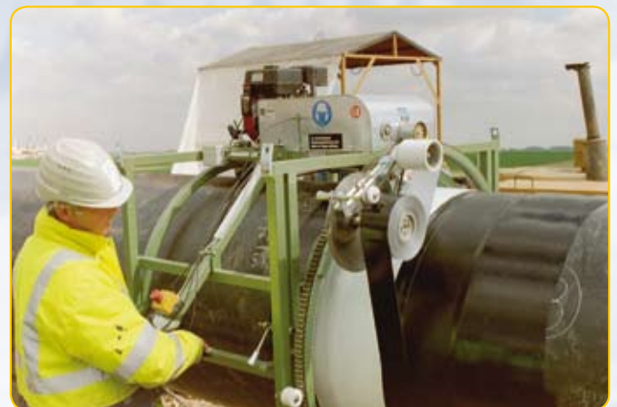
Wickelautomat zum Nachisolieren großer Rohrdimensionen und -abschnitte
