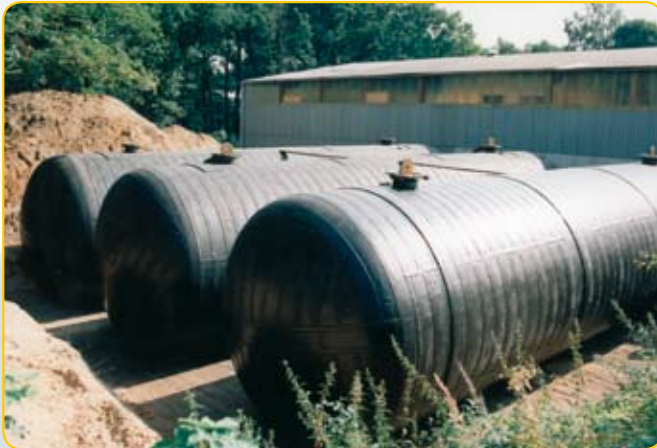
Schrumpfmanschette für die Umhüllung von Schweißverbindungen
