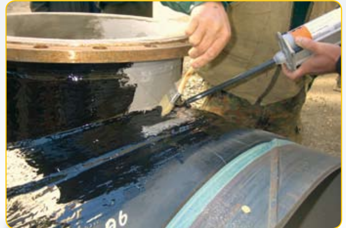
Formteilbeschichtung mit Polyurethan-Streichbeschichtung
