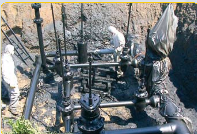
Umhüllungssanierung komplexer Bauteile mit Polyurethan-Heißspritzbeschichtung
