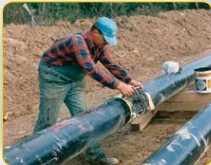
Nachisolierung von Schweißverbindungen mit kaltverarbeitbaren Kunststoffbändern
