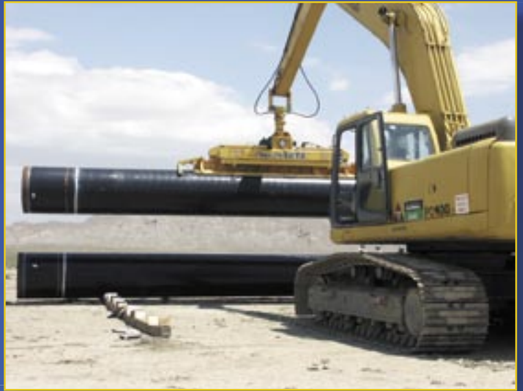
Stapeln von Rohren, fertig zum Absetzen
